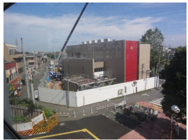
建設中の多摩クリニック
